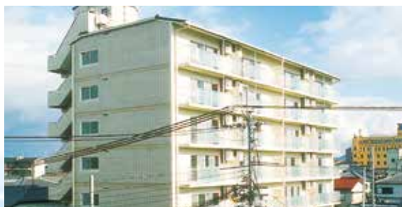
エクセムマンションの全景
