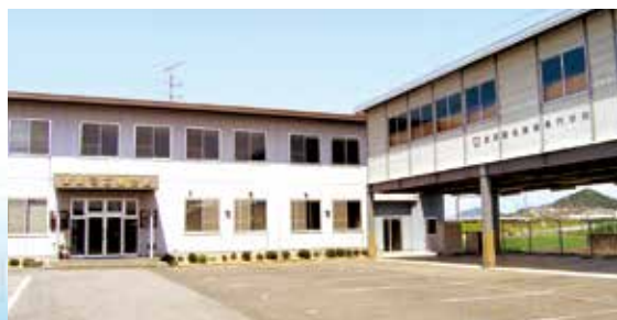
滋賀電工組会館の全景
