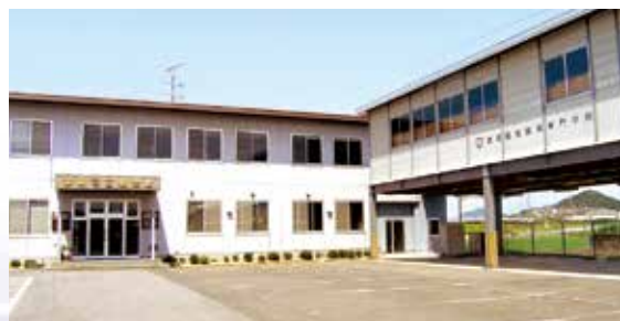
滋賀電工組会館の全景
