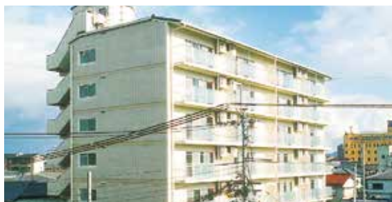
エクセムマンションの全景
